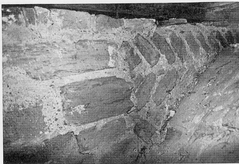
Fig. 6. Vejby. Over hvælvne, sydmurens indvendige side. I hvælvlommen mellem det nuværende 2. og 3. hvælv, regnet fra øst, ses overgangen mellem det romanske skibs vandretliggende hjørnekvadre i det sydøstre hjørne og sydmurens »sildebens-murværk«. Foto: JF 1978
