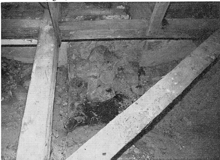
Fig. 3. Vejby. Over hvælvingerne. I hvævlammen mellem 5. og 6. hvælv, regnet fra øst, ses på nærmuren, under de vandretliggende loftsbjælker (bindbjælker) et bevaret stykke af den romanske tårns østmur. Foto: IIF 1978
