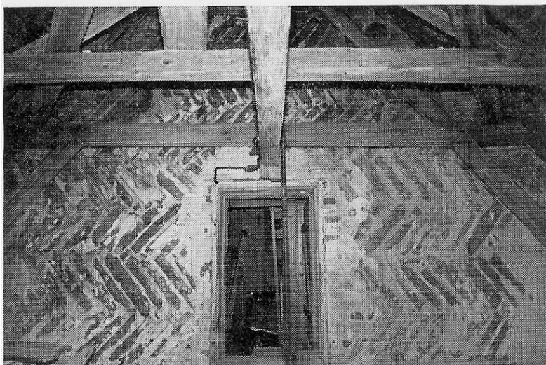
Fig. 7. Vejby. Over hvælvene. Rest af den romanske vestmur, nu del af det nuværende tårns østmur. »Sildebens-murværket«. (Opus Spicatum). Foto: JJF 1978
