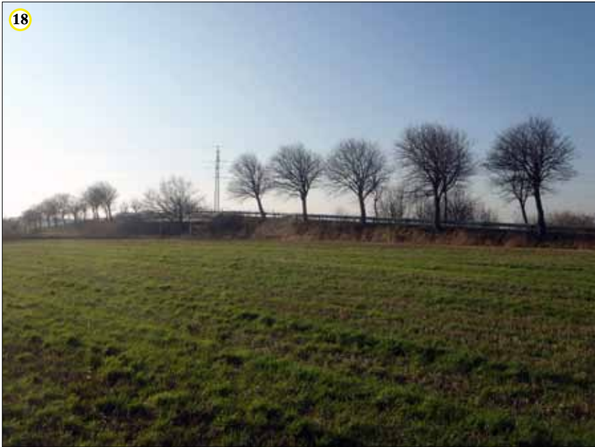
Viadukten af Farvergårdsvej mellem Ørby og Vejby. Et elegant anlæg fra jernbetonbroernes barndom i midten af 1930-erne. Foto: Lars Windfeld-Høeberg
