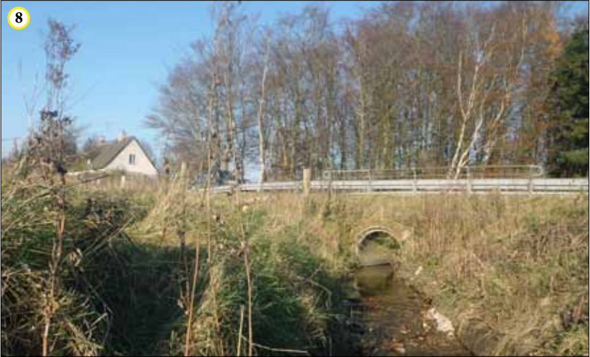
'Overkørslen ved Havegård': Antagelig et gammelt vadested, nu i form af en vejdæmning hen over Øllemose Å, som er ledt gennem et cementrør under Møngevej mellem Vejby og Mønge. Foto: Lars Windfeld-Høeberg
