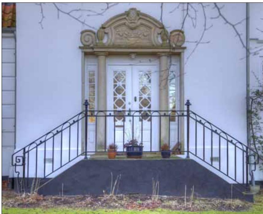
Den monumentale indgangsportal mod nord. Foto: WICTOR
