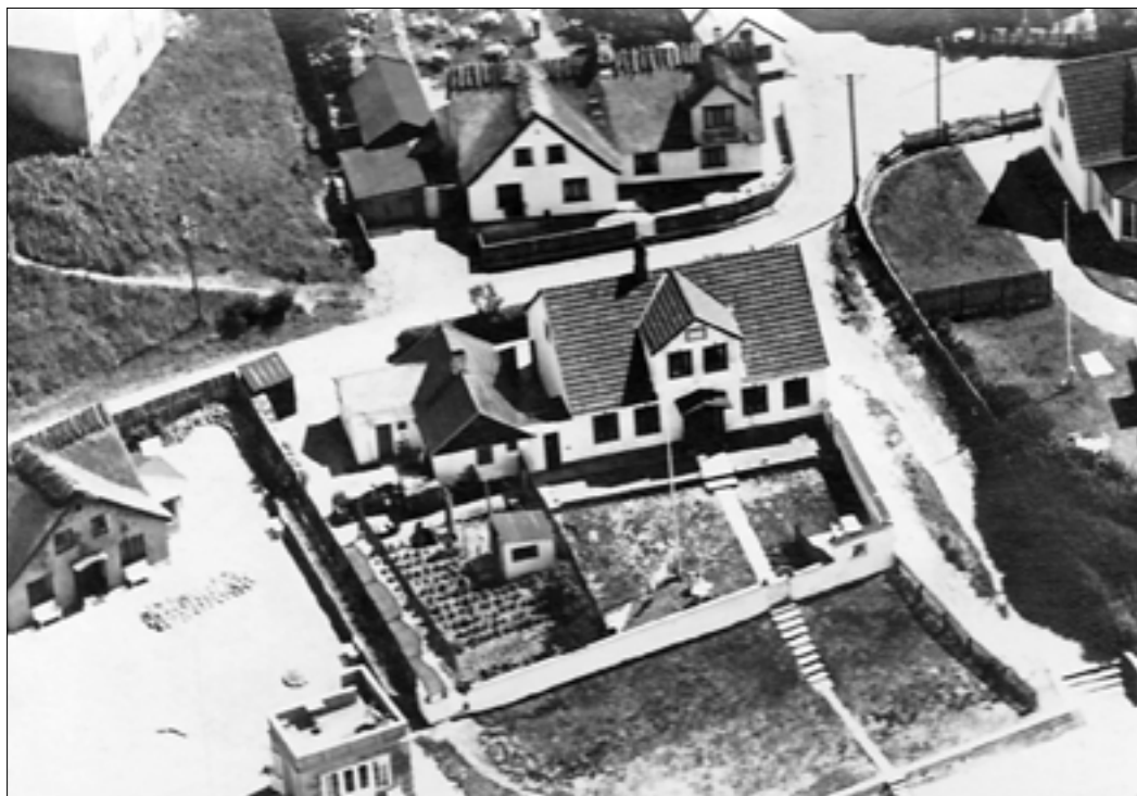
Luftfoto af Ved Stranden 9.
