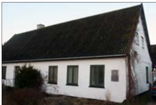
Stationsvej i dag. Tavlen er flyttet en smule i forbindelse med ombygning i forhold til den oprindelige placering.
